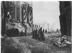
Construction of the avenue de l'Opéra.
